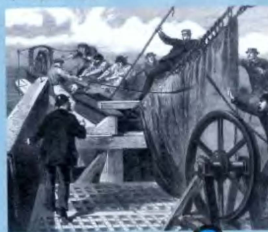
Во время прокладки первого кабеля произошел обрыв.
